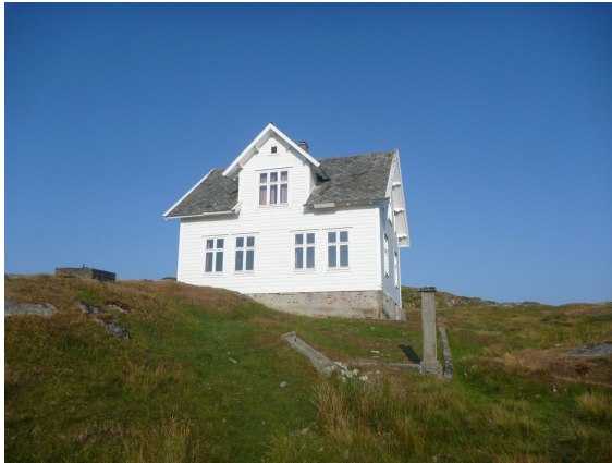
«Martin-huset» i 2018. Det ble bygget i 1912 i sveitserstil.
