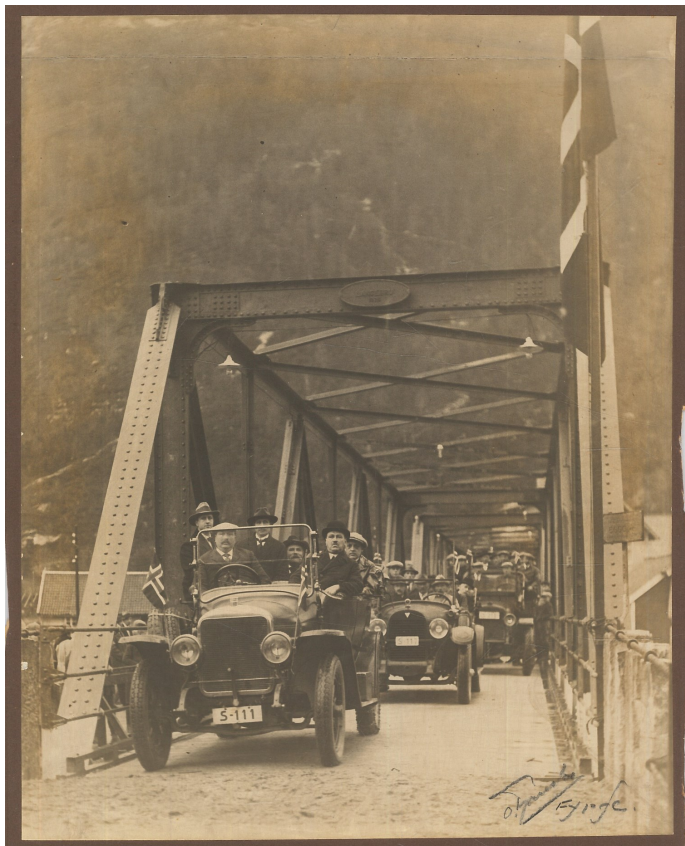
Langebrua ble åpnet for trafikk 20. november 1925. Det var mange framømte og høy stemning da S-111 fra Firda billag ledet prose-sjonen. Hentet fra arkivet til Sogn og Fjordane vegvesen. Førde 17, boks 7A.
