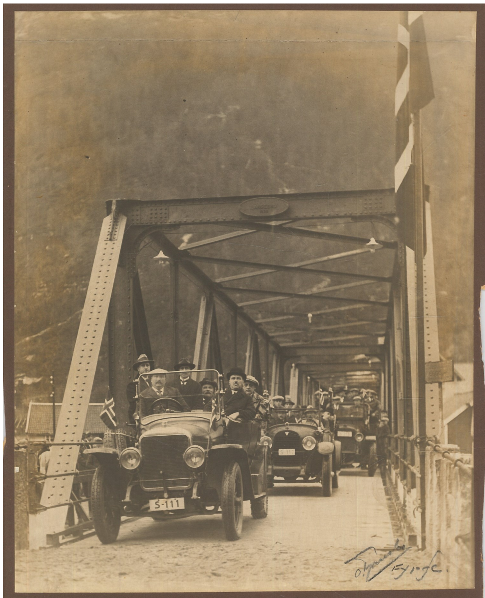
«Langebrua vart opna for trafikk 20. november 1925. Det var mange framømte og høg stemning. S-111 frå Firda billag leia prosesjonen.» (Henta frå arkivet til Sogn og Fjordane vegvesen. Førde 17, boks 7A.)
