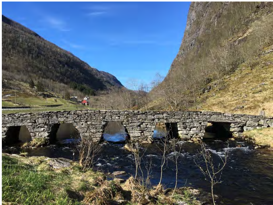
Ytredal bru i Vadheim, i passet der Amund Helland hevda at storparten av kortskallane i Ytre Sogn måte ha innvandra frå Sunnfjord.
