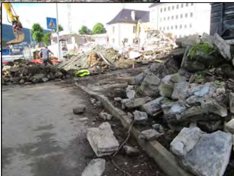
Under: Konserve- ringsbygget under riving, sett fra Stem- meveien.
